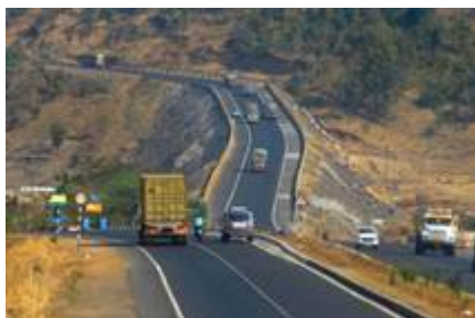
(Steel Slag Road)
